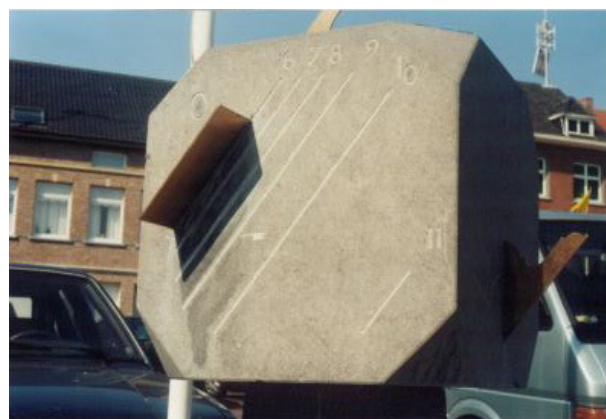
Foto 3: Oost zonnewijzer te Rupelmonde (meervlakzonnewijzer)
